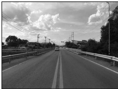
ภาพถ่ายด้านบนสะพาน (กม.น้อย - กม.มาก)
