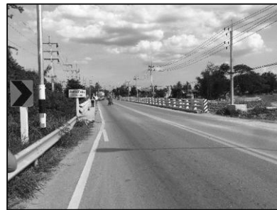
ภาพถ่ายด้านบนสะพาน (กม.มาก - กม.น้อย)
