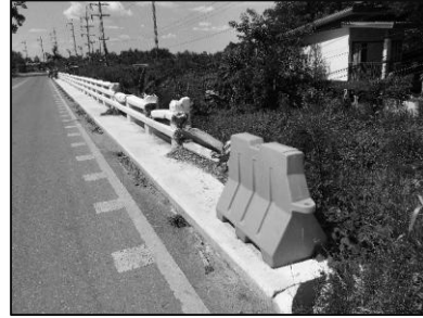
ราวสะพานด้านขวา (กม.น้อย - กม.มาก)
