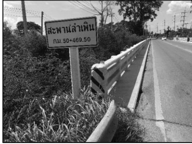
ราวสะพานด้านซ้าย (กม.น้อย - กม.มาก)
